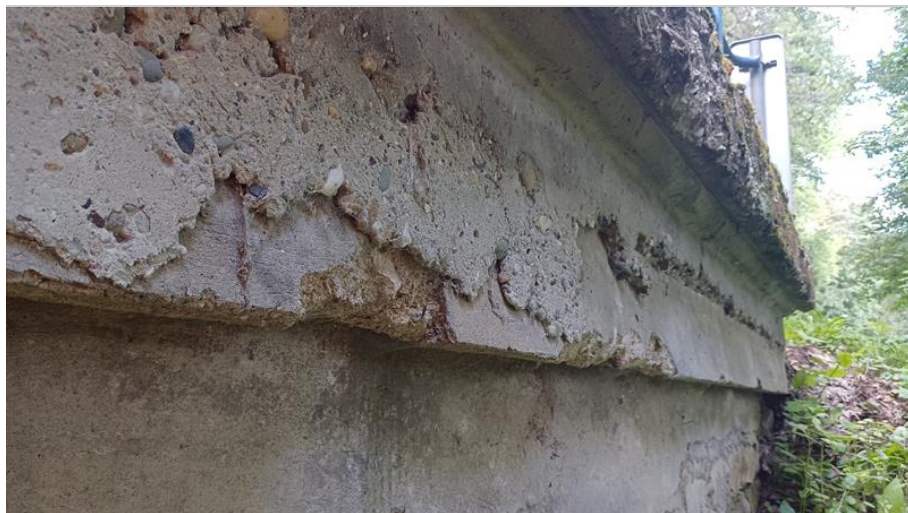
Lokálně obnažena výztuž na podhledu NK
