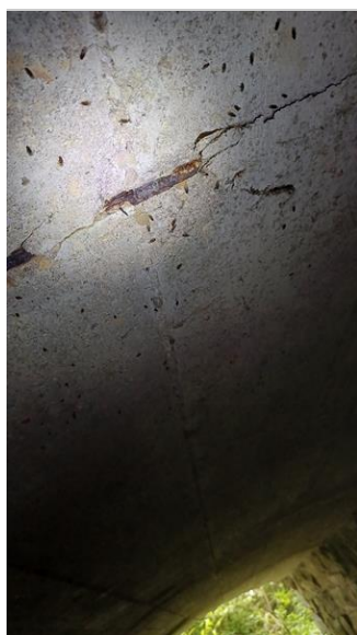
Lokálně obnažena výztuž na podhledu NK
