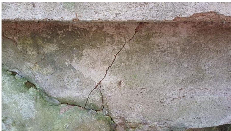
Trhlina na přechodu NK na operu OP2 vlevo
