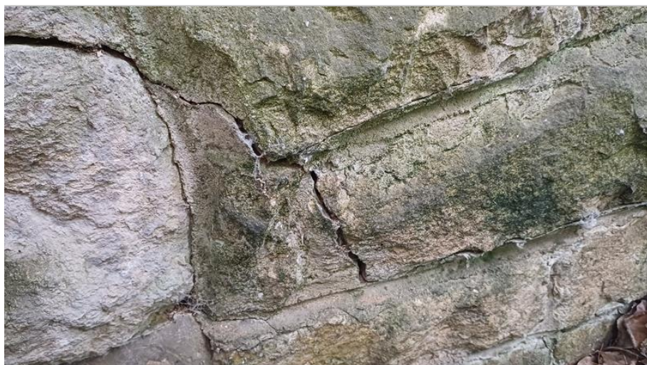
Trhlina v křídle opěry OP1 na levé straně
