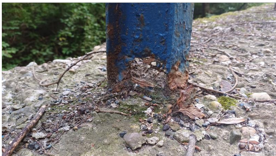
Koroze sloupku zábradlí
