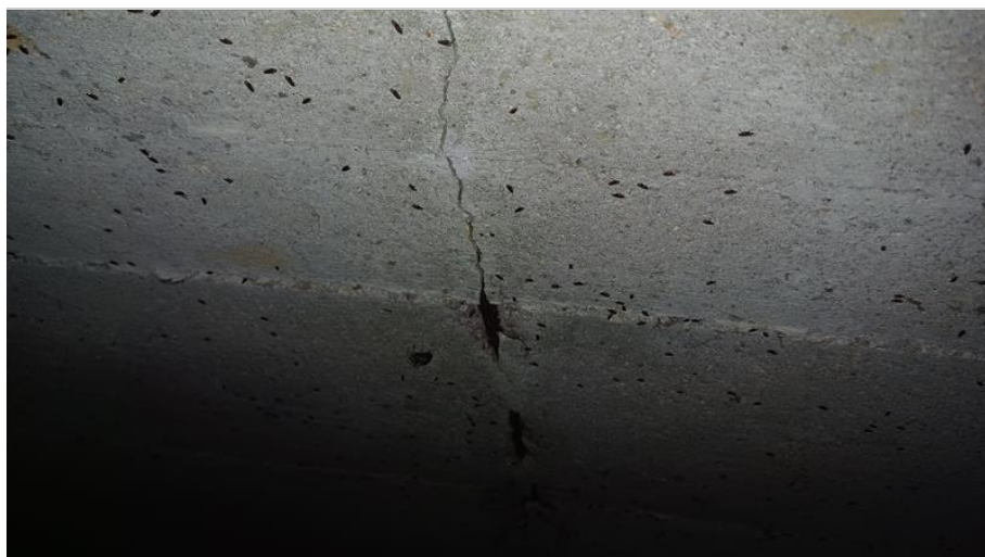
Trhlina na podhledu NK uprostřed
