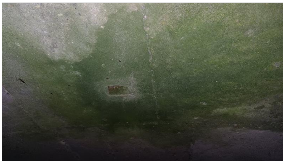
Stopy po zavlhnutí na pravé straně NK
